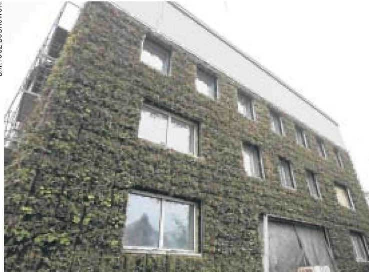
Tak wygląda gotowa już ściana modernizowanej willi
